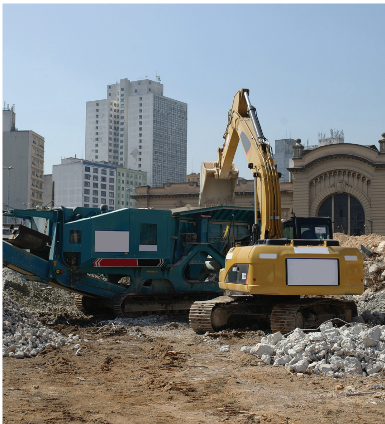
Britadores móveis arrendados pela Britex foram utilizados na desconstrução do Treme-treme, no Centro de São Paulo.
